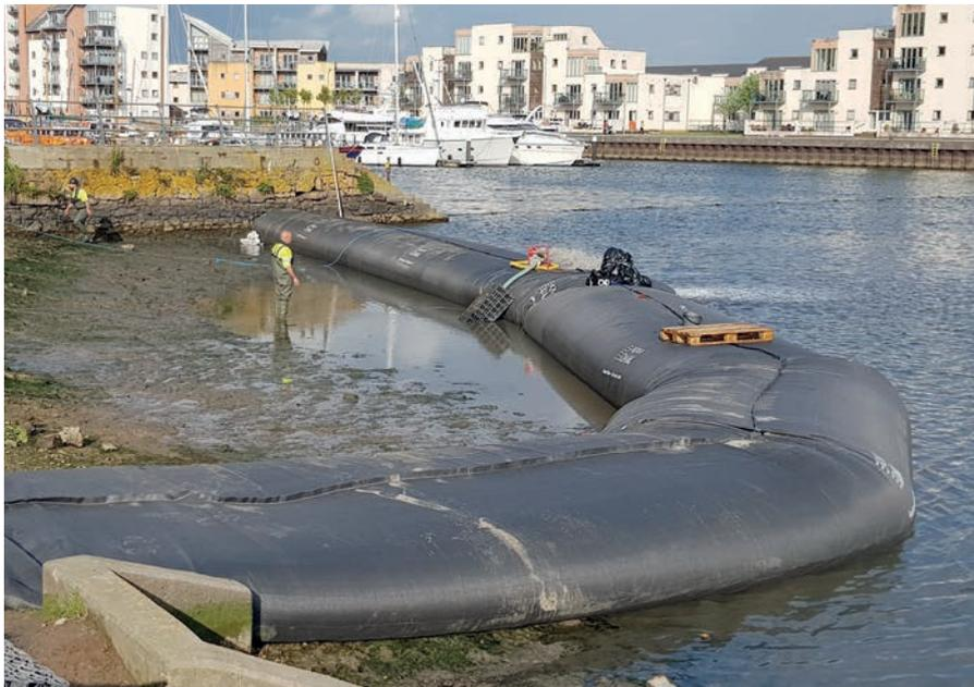
Disponemos de todo tipo de soluciones para el sector de la construcción, en el que, en ocasiones, se debe realizar una contención de aguas en terrenos muy irregulares.
