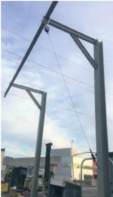
Las líneas de vida para la descarga de cisternas son unos sistemas de prevención y evitan cualquier posibilidad de caída de un operario durante un desplazamiento horizontal. Nuestro equipo diseña y construye líneas de vida rígidas, permanentes por riel.
